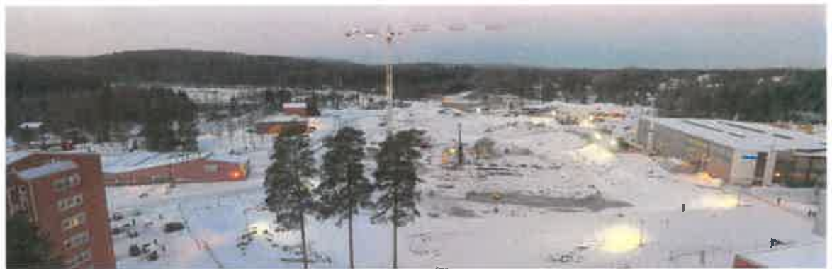
Kuva 2, Uuden sairaalan rakennustyömaa 5.1.2017
